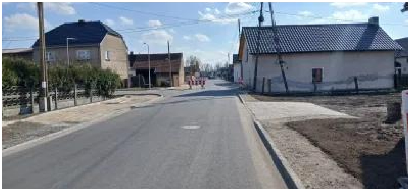
Ulica Spóracka w przebudowie
