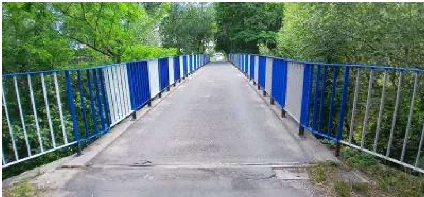
Remont poręczy mostu na ul. Młyńskiej
